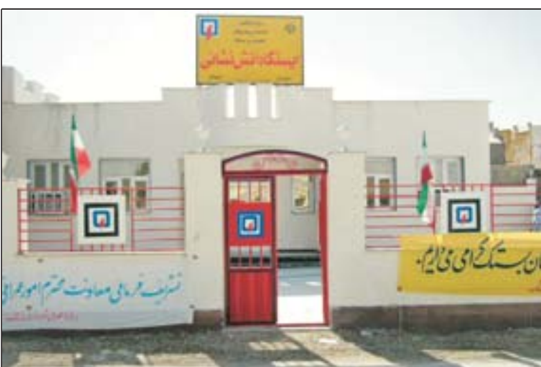
◀ ساختمان آتش نشانی
