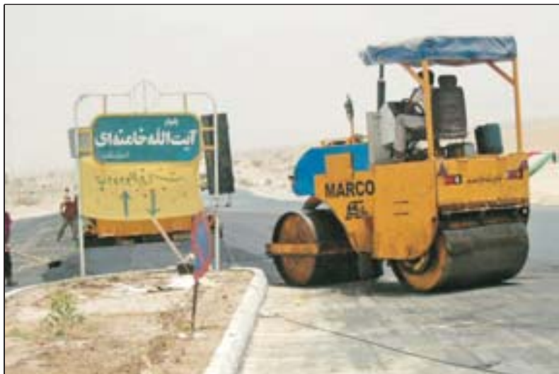
◀ احداث آسفالت بلوار ورودی لار
