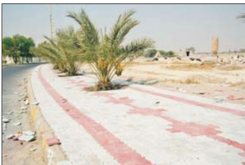
◀ احداث پیاده رو
